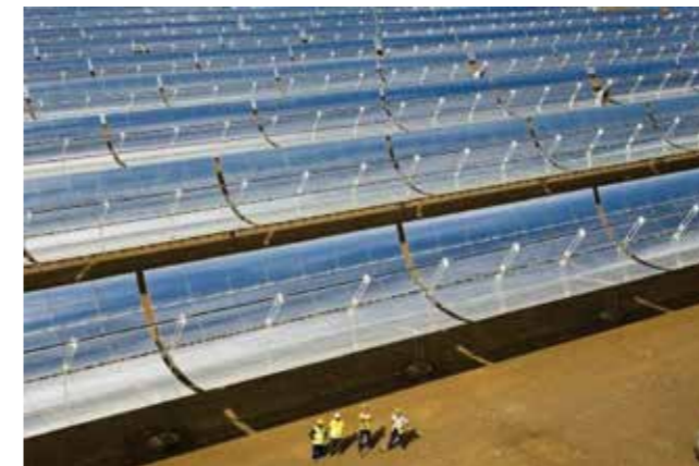
Solarthermische Kraftwerke (Bild: Solarmillennium)
