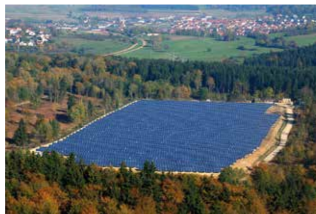
Solarpark Engstingen-Haid (Quelle: SWTübingen / Baltzer, Solarpark)
